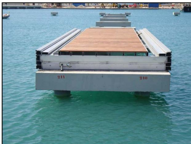
Imagen 8. Sección tipo del pantalán fijo con placa de aluminio.
