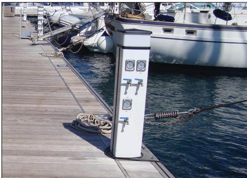
Imagen 5. Bloques de servicio instalados en Pantalán Flotante
